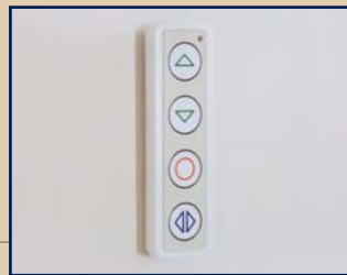
Kabellose Steuerung am Ankunfts-/Ausgangsort
